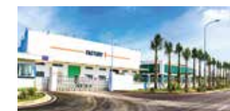
Nhà xưởng xây sẵn hoặc nhà xưởng xây theo yêu
